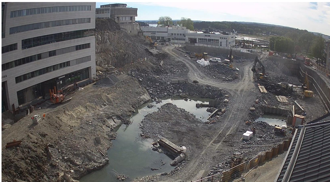
Status byggegrøp 18. mai 2022
