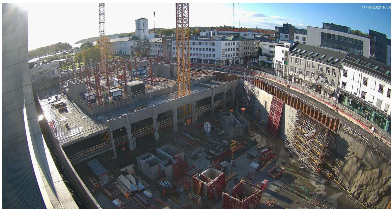
Bilde fra byggeplassen 11. oktober.
