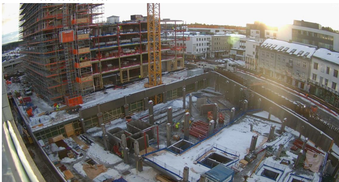
Bilde fra byggeplassen 22 januar 2024.
